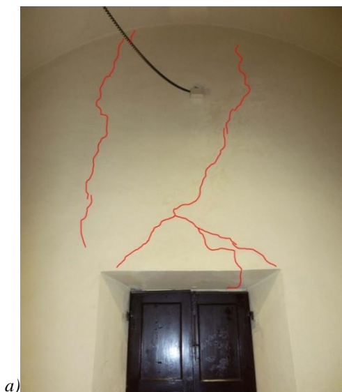
Figura 7.4: Dettagli delle lesioni: a) PT-41-L5 (lesione grave), b) PT-41-L4 (lesione intermedia).
