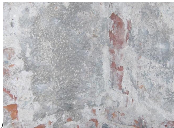
Figura 6.7: a) Muratura in mattoni pieni e pietre a spacco sbazzate, TM+C/13A/PT, b) Muratura in mattoni pieni e pietre squadrate, TM+C/42Bis/PT
