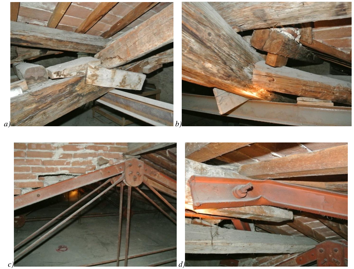
Figura 6.62: a-b) Dettagli degli appoggi delle capriate (lato Piazza Dante interno portico, angolo con Vicolo dell'Ulivo), c) muretti in mattoni pieni sopra il corrente superiore, d) dettaglio aggancio profili metallici.
