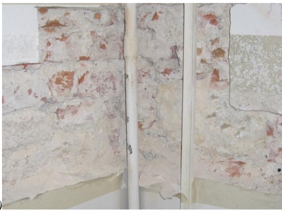
Figura 6.7: a) Muratura in mattoni pieni e pietre a spacco sbazzate, TM+C/13A/PT, b) Muratura in mattoni pieni e pietre squadrate, TM+C/42Bis/PT
