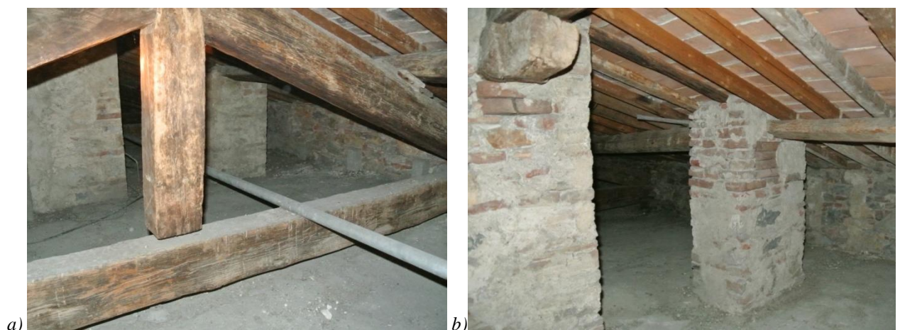
Figura 6.58: a) Capriate in legno lato Via della Sapienza, b) appoggio travi longitudinali su muretti in mattoni pieni.
