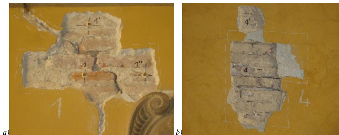
Figura 9.5: a) Indicazione punto di misura n°1 e b) Indicazione del punto di misura n°4 al piano terra.
