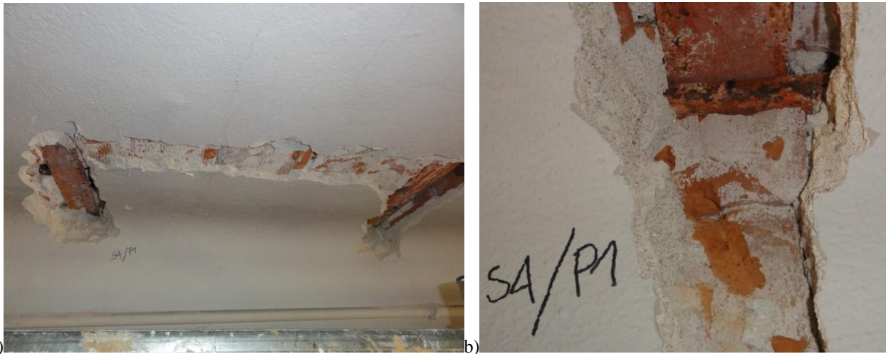
Figura 6.35: Solaio a doppia orditura (saggio S4/P1), profili trave principale 2IPN400, profili orditura secondaria IPN160 interasse 85 cm (stanza P1-3).
