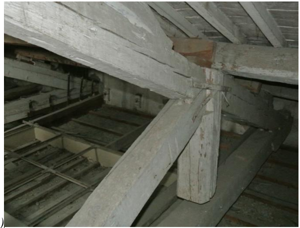
Figura 6.54: a) Capriate in acciaio lato Piazza Dante, b) capriate in legno lato Piazza Dante (verso porticato interno).
