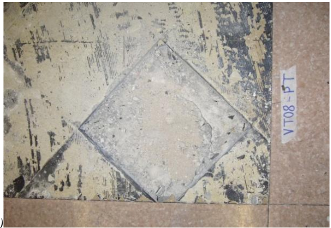
Figura 6.50: a) Individuazione in pianta dei saggi, Volta 08 PT; b) Schema della sezione dell'orizzontamento, Volta 08 PT; c) Saggio all'intradosso, Volta 08 PT; d) Saggio all'estradosso, Volta 08 PT.
