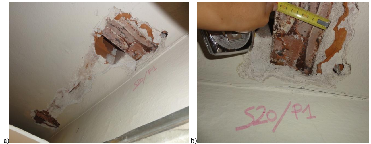
Figura 6.33: Solaio a semplice orditura (saggio S20/P1), profili tipo IPN220 a passo 85 cm (stanza P1-35).
