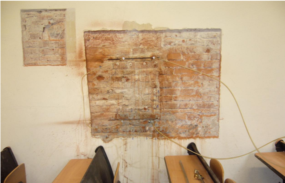
Figura 8.11: Esecuzione della prova Mart/25/PT.
