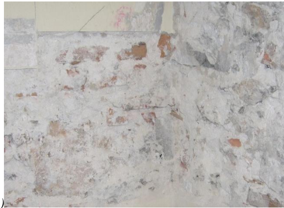
Figura 6.6: a) Muratura in mattoni pieni, TM+C/44/PT, b) Muratura in mattoni pieni e pietre a spacco irregolari, TM+C/08/PT.
