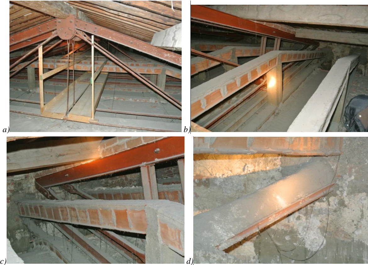
Figura 6.60: a) Copertura Aula Magna Nuova, b-c) dettagli copertura, d) rivestimento del tirante inferiore della capriata a sostegno della volta.
