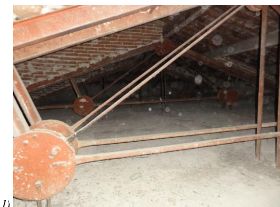
Figura 1.9: Varie tipologie di orizzontamento presenti all'interno del Palazzo della Sapienza: a) volta a crociera in prossimità di un ingresso, b – c) volte con lunette, d) solaio piano con travi ricalate, e) solaio piano di cui si individua l'orditura, f) solaio con profili metallici e voltine, g – h) tetto con capriate di legno, i-l) tetto con capriate di acciaio.
