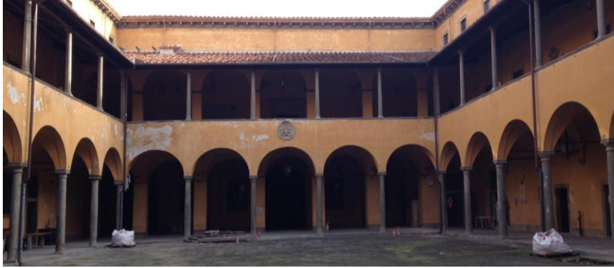
Figura 11.12: Disallineamento tra i pilastri del porticato al piano terra e quelli del piano primo.
