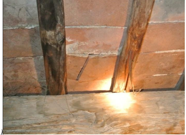
Figura 6.65: Copertura in legno (lato Vicolo dell'Ulivo): a) dettagli dei travicelli ammalorati e b) lesioni sulle tavelle.
