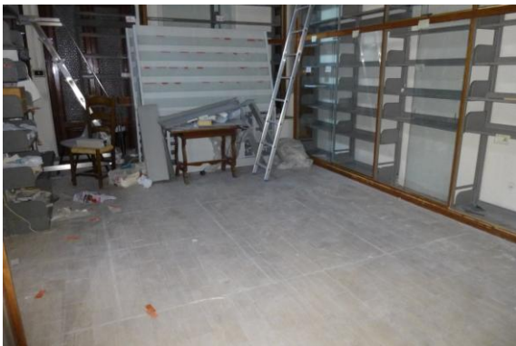
Solaio in assenza di carico
