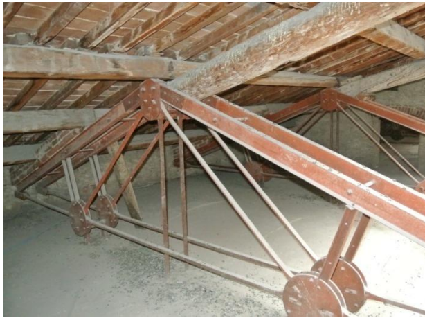
Figura 6.54: a) Capriate in acciaio lato Piazza Dante, b) capriate in legno lato Piazza Dante (verso porticato interno).
