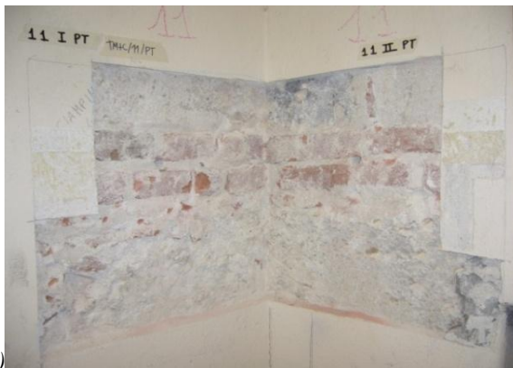
Figura 6.8: a) Muratura in mattoni pieni e pietre squadrate con ricorsi, TM+C/11/PT, b) Muratura in pietre a spacco irregolari, TM/09B/PT.
