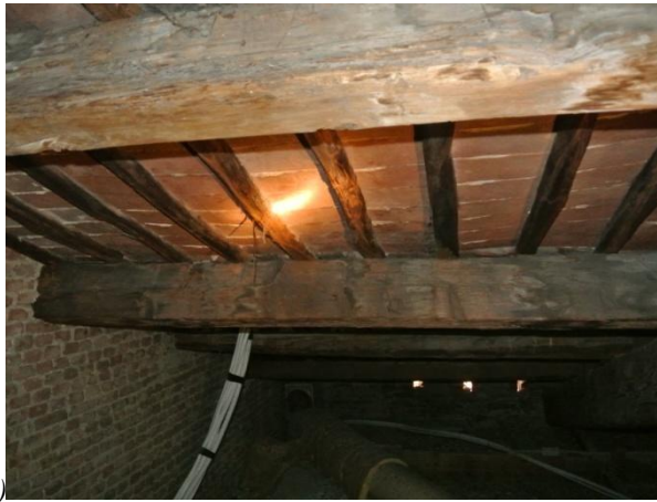
Figura 6.65: Copertura in legno (lato Vicolo dell'Ulivo): a) dettagli dei travicelli ammalorati e b) lesioni sulle tavelle.
