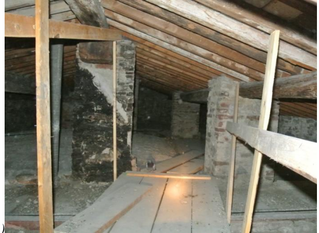
Figura 6.66: Muretti in laterizio a sostegno della copertura: a) lato Piazza Dante (interno porticato), b) lato Vicolo della Sapienza.
