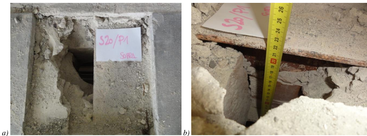
Figura 6.37: Saggio solaio S20/P1 dal piano secondo, individuazione degli strati di riempimento.
