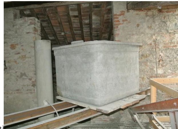
Figura 6.67: a) Lucernai e b) serbatoio appoggiato in corrispondenza del sottotetto lato Piazza Dante.
