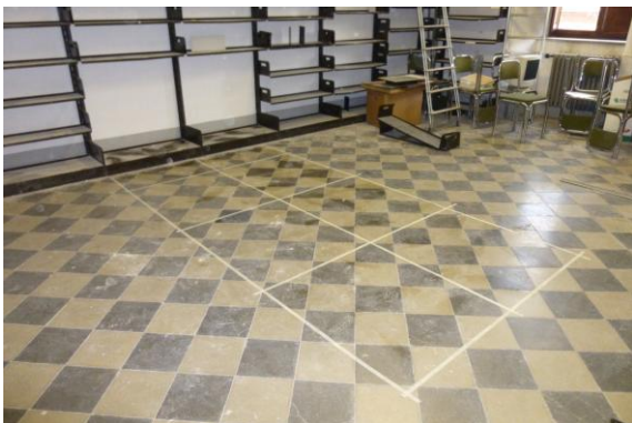
Solaio in assenza di carico
