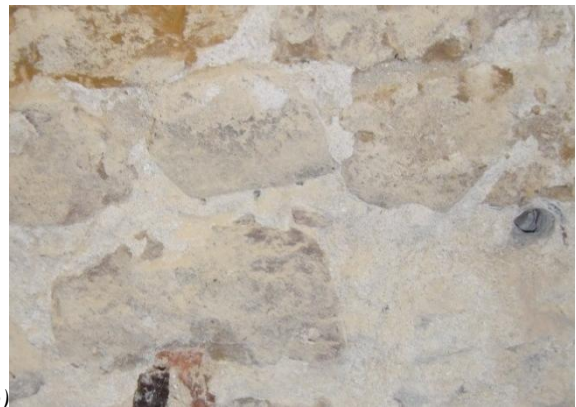
Figura 6.8: a) Muratura in mattoni pieni e pietre squadrate con ricorsi, TM+C/11/PT, b) Muratura in pietre a spacco irregolari, TM/09B/PT.
