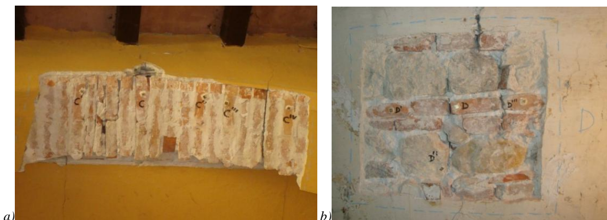
Figura 9.16: a) Indicazione del punto di misura C al piano primo (arco in corrispondenza della copertura del porticato), b) indicazione punto di misura D al piano secondo.
