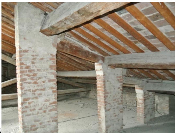
Figura 6.66: Muretti in laterizio a sostegno della copertura: a) lato Piazza Dante (interno porticato), b) lato Vicolo della Sapienza.
