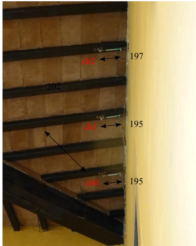
Schema di posizionamento dei trasduttori
