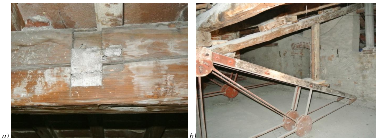
Figura 6.69: a) Dettaglio intervento su trave in legno, b) inserimento montante in legno in corrispondenza della capriata in acciaio (lato Piazza Dante).
