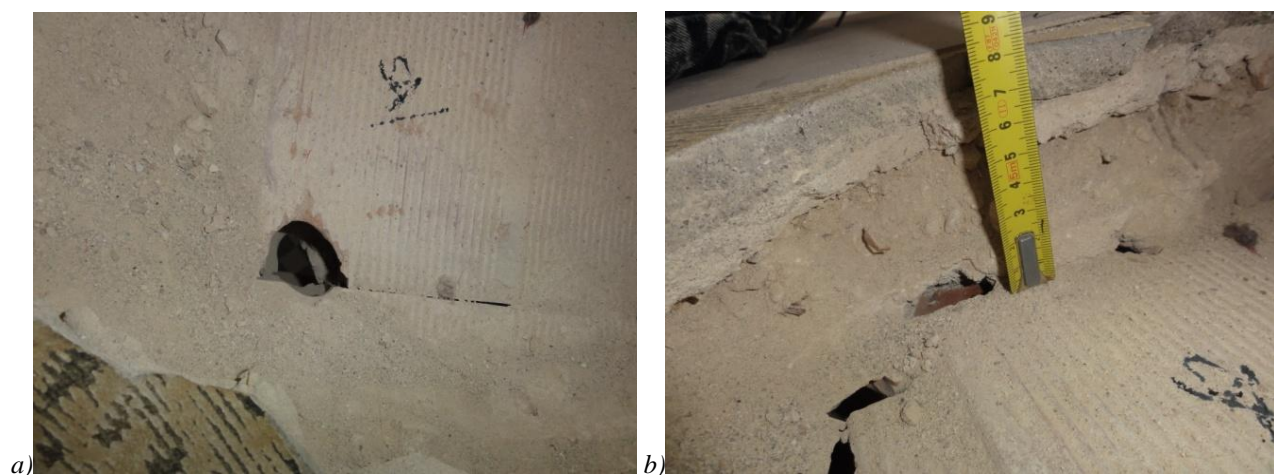
Figura 6.39: Saggio solaio S4/P1 dal piano secondo, individuazione degli strati di riempimento.
