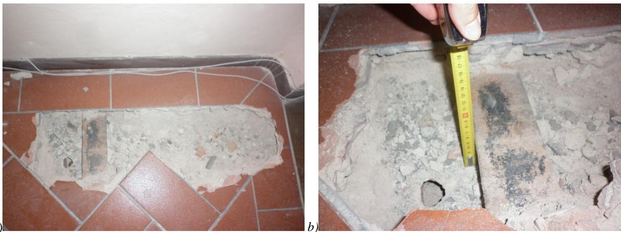
Figura 6.36: Saggio solaio S9/PT dal piano primo, individuazione degli strati di riempimento.
