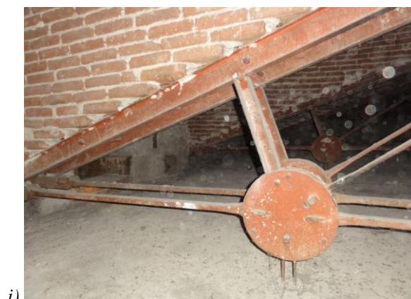
Figura 1.9: Varie tipologie di orizzontamento presenti all'interno del Palazzo della Sapienza: a) volta a crociera in prossimità di un ingresso, b – c) volte con lunette, d) solaio piano con travi ricalate, e) solaio piano di cui si individua l'orditura, f) solaio con profili metallici e voltine, g – h) tetto con capriate di legno, i-l) tetto con capriate di acciaio.
