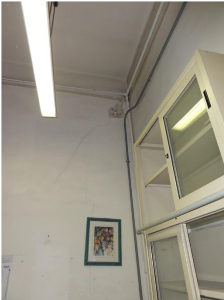
Figura 7.8: a) Locale PT-21, dettaglio lesione PT-21-L1, b) Locale PT-17, dettaglio PT-17-L2.
