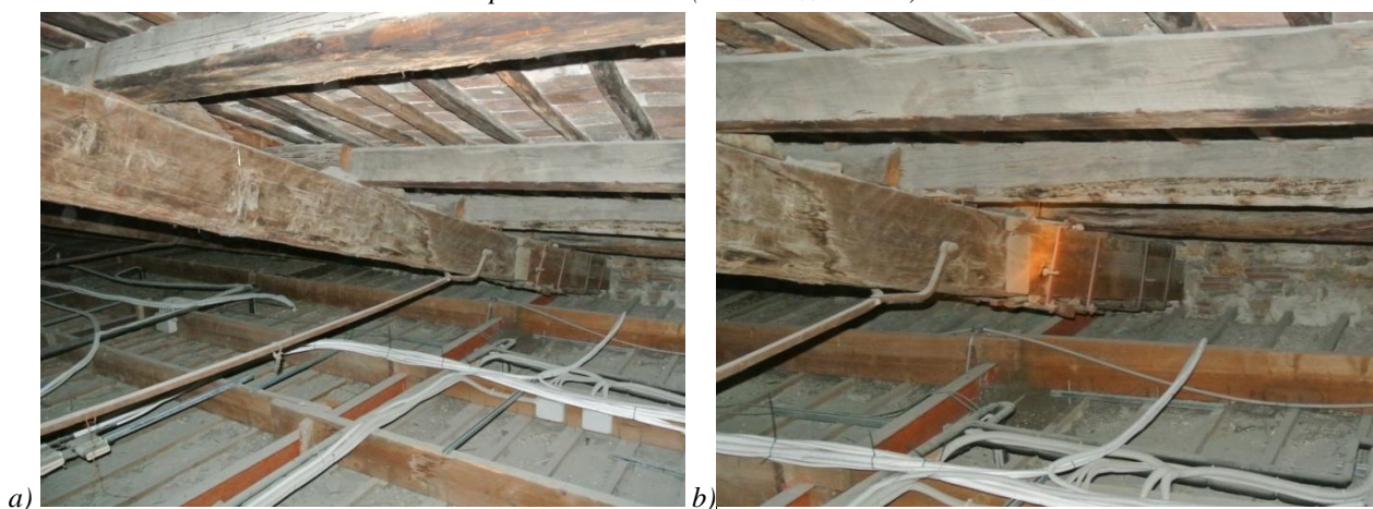
Figura 6.70: Capriate in legno nel sottotetto lato Vicolo dell'Ulivo: in intervento eseguito su una trave in legno.
