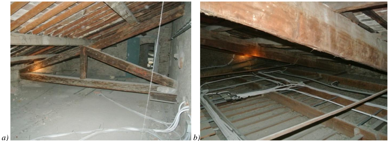
Figura 6.56: Capriate in legno nella copertura lato Vicolo dell'Ulivo.
