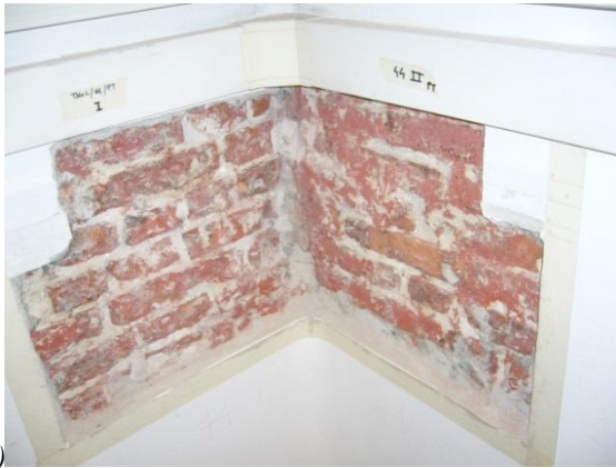
Figura 6.6: a) Muratura in mattoni pieni, TM+C/44/PT, b) Muratura in mattoni pieni e pietre a spacco irregolari, TM+C/08/PT.
